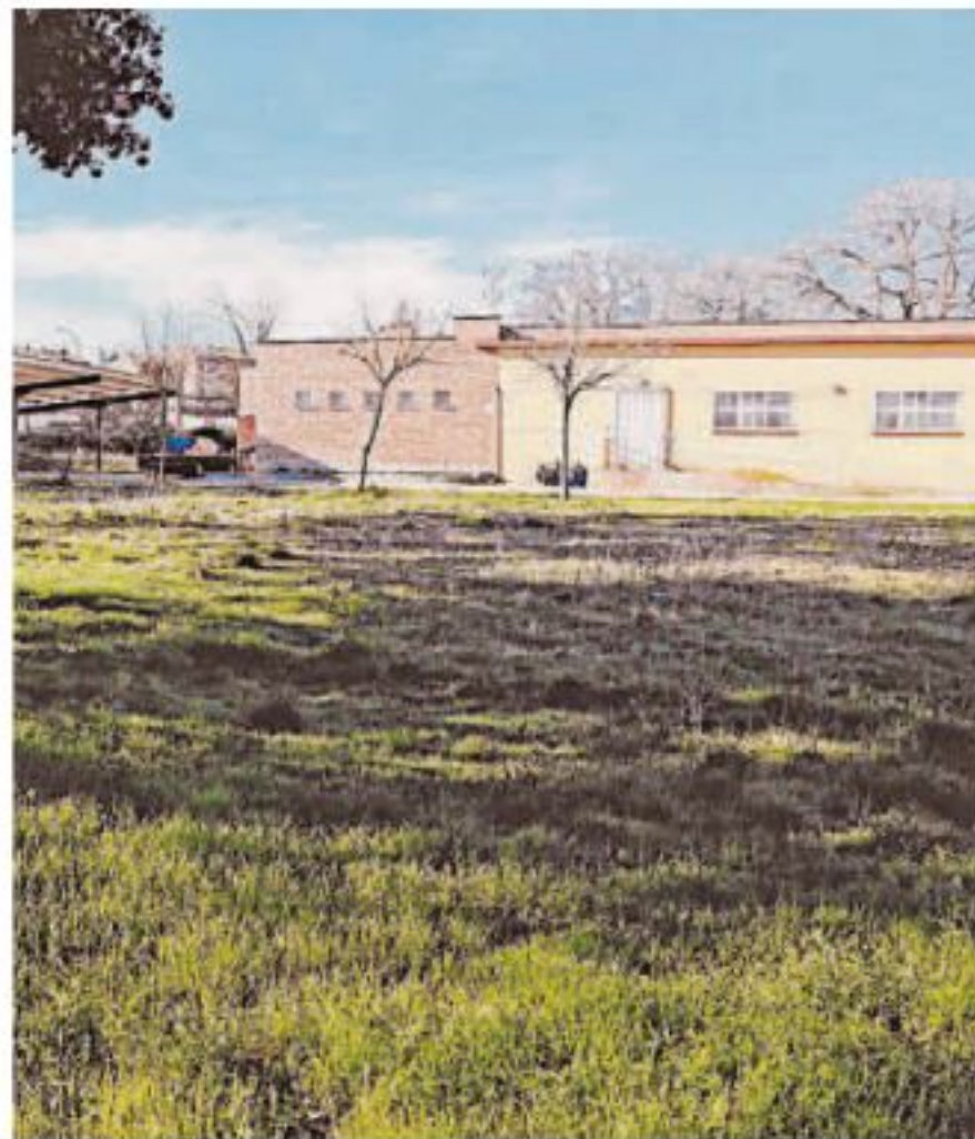
Terreno donde se ubicará el nuevo centro de actividades económicas.
