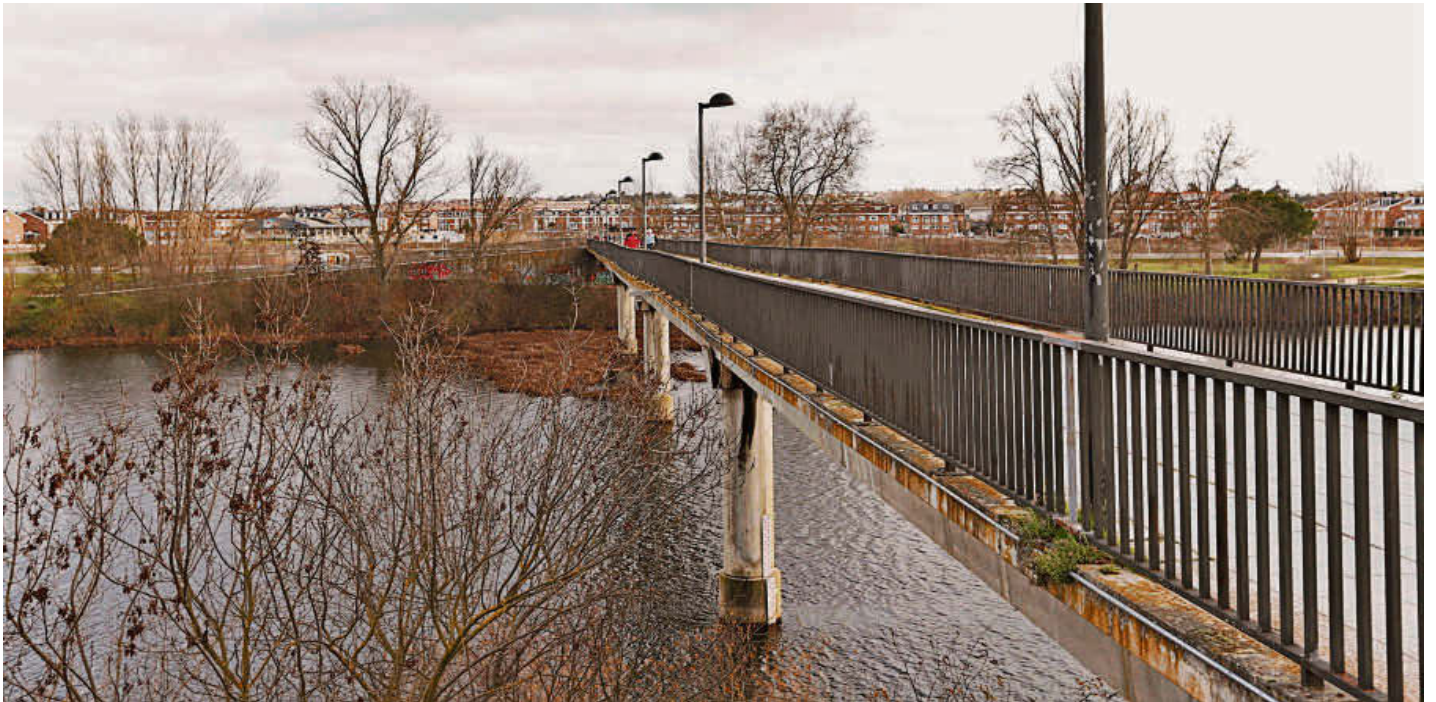
LA FONTANA (2000): SUMINISTRO DE AGUA POTABLE A LA MARGEN IZQUIERDA. La conducción del nuevo abastecimiento desde la Estación de Tratamiento de la Aldehuela hacia los barrios trastormesinos hizo posible a fines del siglo pasado la pasarela desde el polígono de El Tormes a la urbanización La Fontana.
