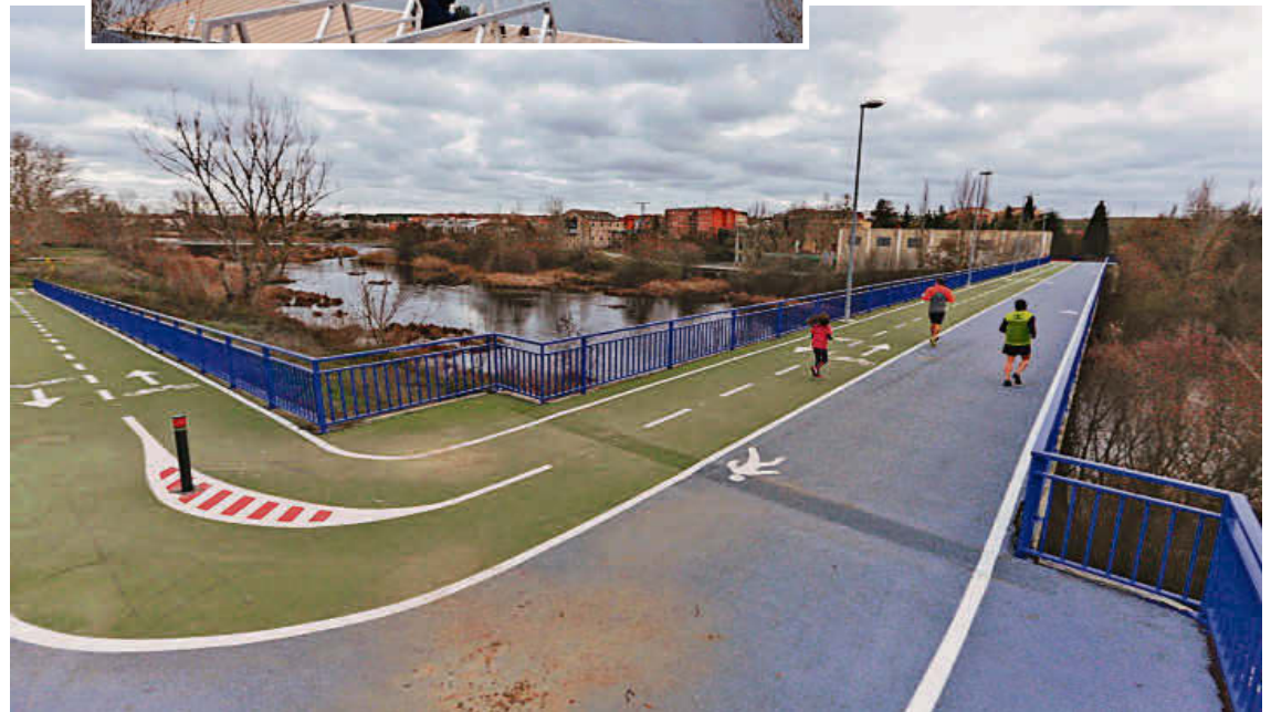
TEJARES. NUEVA IMPULSIÓN DE AGUAS RESIDUALES (2003). La pasarela construida sobre la conexión hacia la nueva EDAR en El Marín acaba de ser renovada e incluida en la red de carriles bici del área metropolitana.
